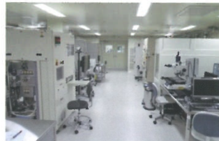
クリーンルーム
